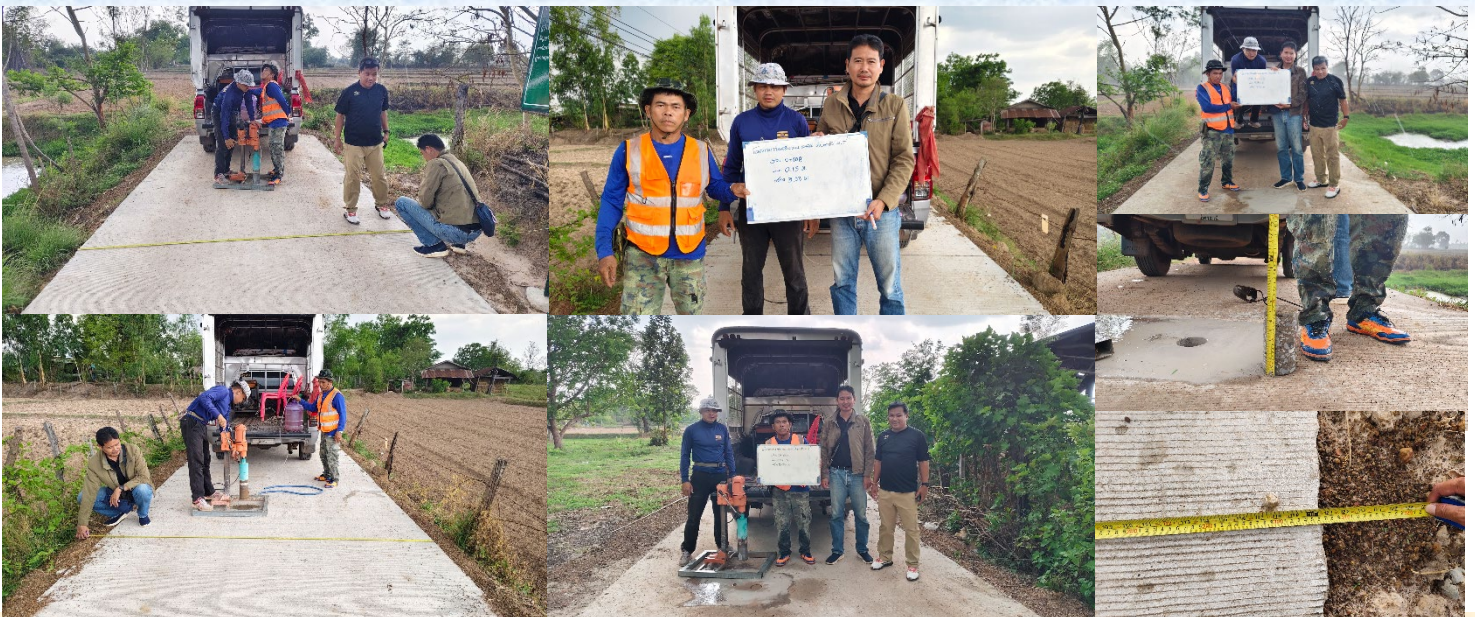
คณะกรรมการตรวจรับพัสดุพร้อมด้วยผู้ควบคุมงานได้ออกแจกตรวจสอบความหนาของคอนกรีต ถนนสายไปวัดป่าบ้านนาฮ้าง
