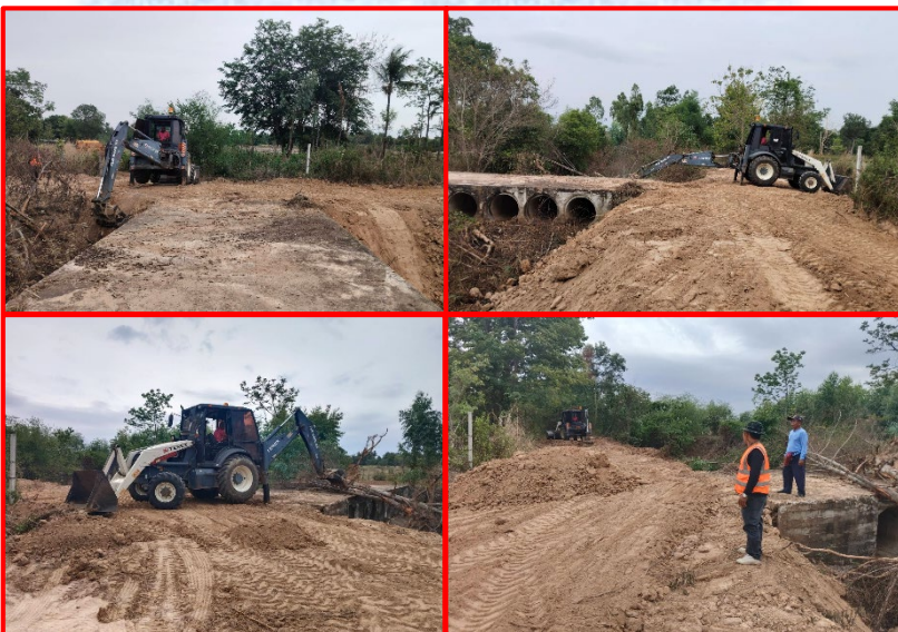
ซ่อมฝายชะลอน้ำลำห้วยคุ่มปูน บ้านหนองบัว
